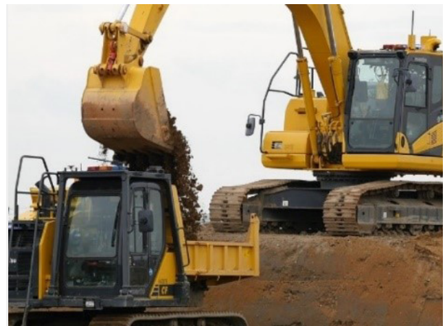
協調・自律稼働する建機のデモンストレーション(2018年10月、「CEATEC JAPAN 2018」にて)。完全無人の油圧ショベルとクローラダンプが、自律的に掘削・旋回・積込みを行い、指定場所に運搬・排土する模様をご覧ください。
