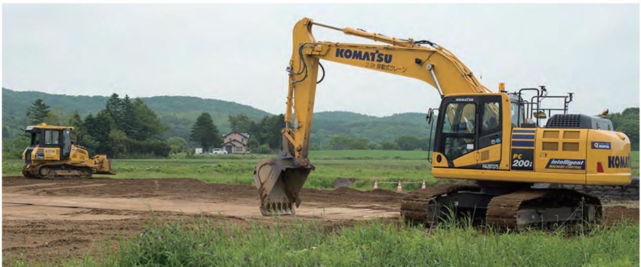
砂子組が施工中の道路建設工事（総延長：780m、掘削土量：38,600m<sup>3</sup>、盛土量：64,000m<sup>3</sup>）では、ICT油圧ショベルPC200i-10とICTブルドーザーD37PXi-23がそれぞれ2台稼働しています（2016年6月の取材時点）。また、KomConnectによる振動ローラー転圧管理（オプション）の導入も予定しています。
