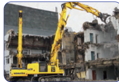
解体ロングフロント
